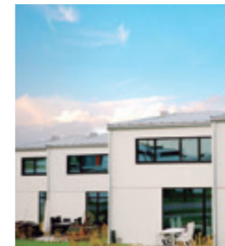
A Brabrand Boligforening 75 alacsony energiafelhasználású házat épített az Århus közelében fekvő Hasselagerben. AQUAREA
